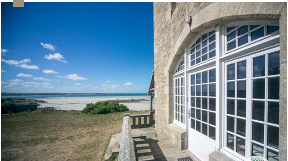
Renovation de l'ancien avec petits bois collés et imposte fixe
