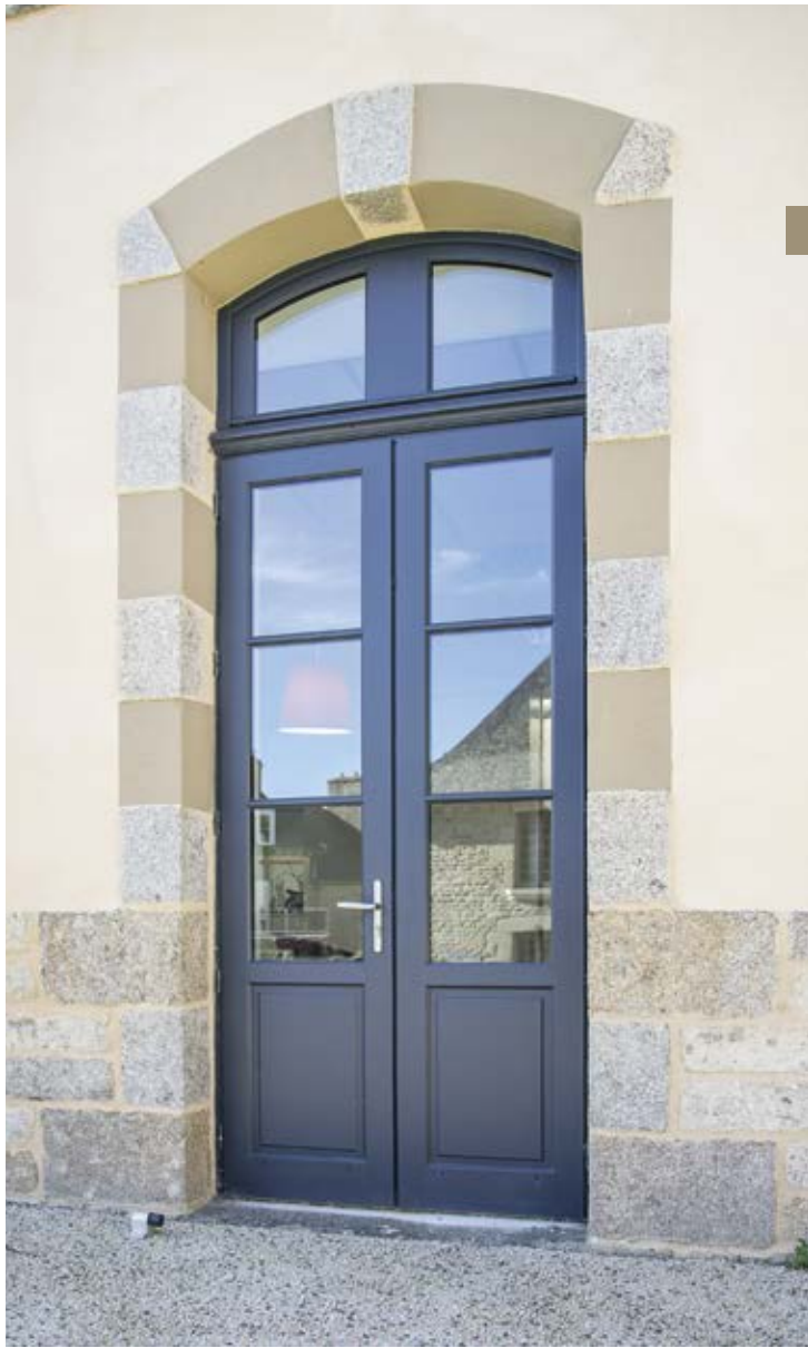
Renovation de l'ancien avec petits bois collés et imposte fixe
